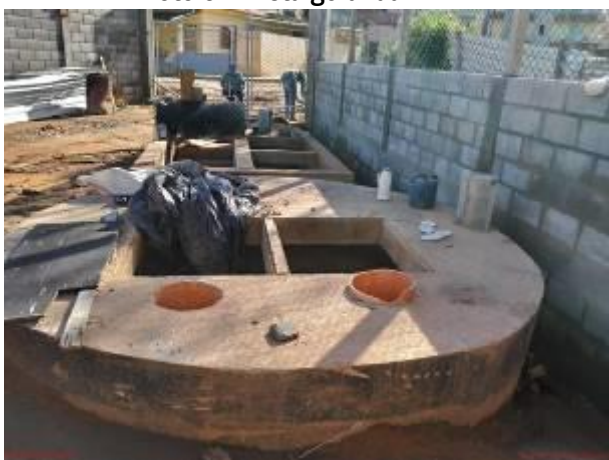
Foto 03: Vista Poço de Sucção
