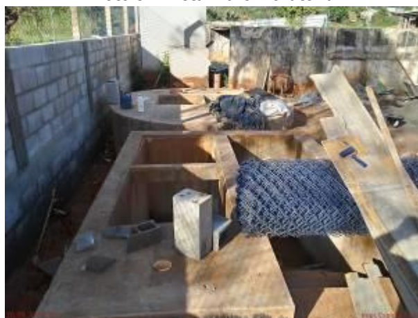
Foto 04: Vista Poço de Sucção e Caixa de Areia
