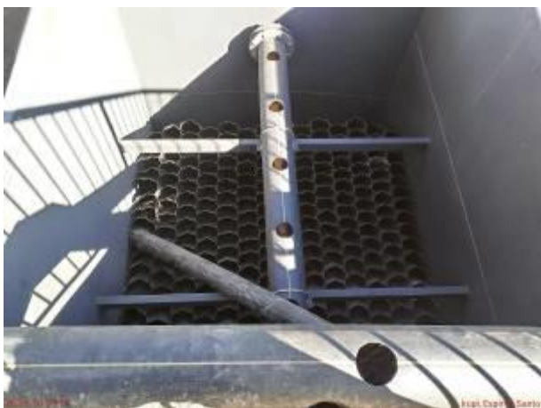
Foto 07: Vista das Lamelas do decantador
