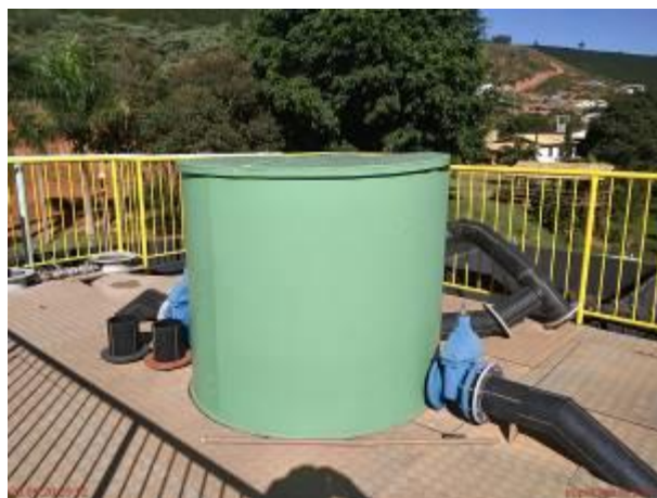
Foto 06: Caixa de Distribuição / Válvulas
