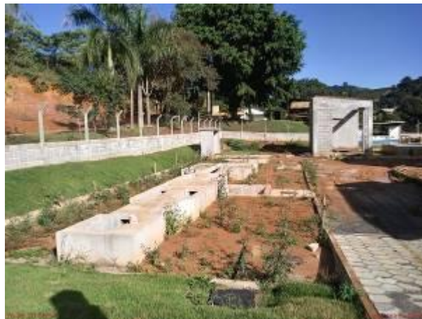
Foto 02: Caixa de Areia / Gradeamento
