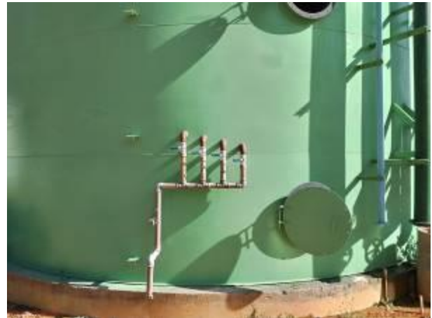
Foto 02: Vista Tubulação Coleta de Amostras
